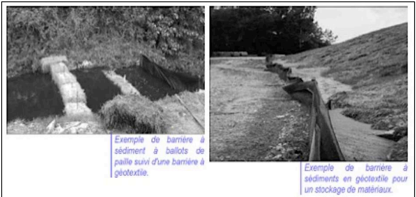
Figure 72 : Exemple de rétention de sédiments : Ballots de pailles ou fibre coco, géotextiles.
