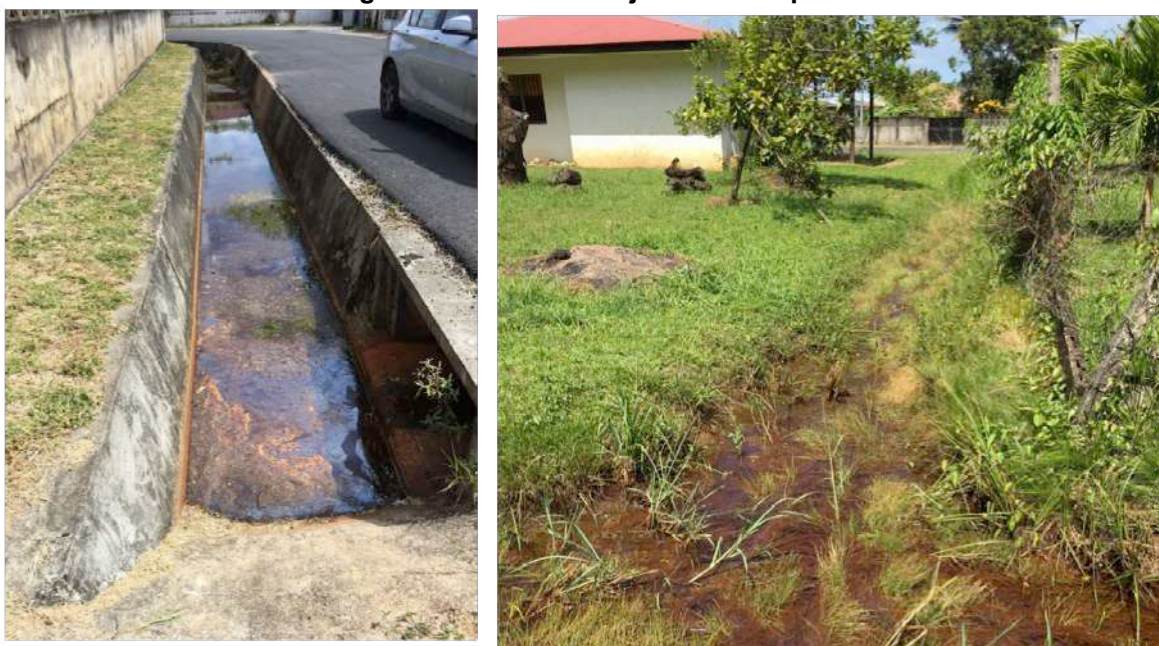
Figure 17 : Photo 1 et 2 Rejet eaux pluviales actuel.
